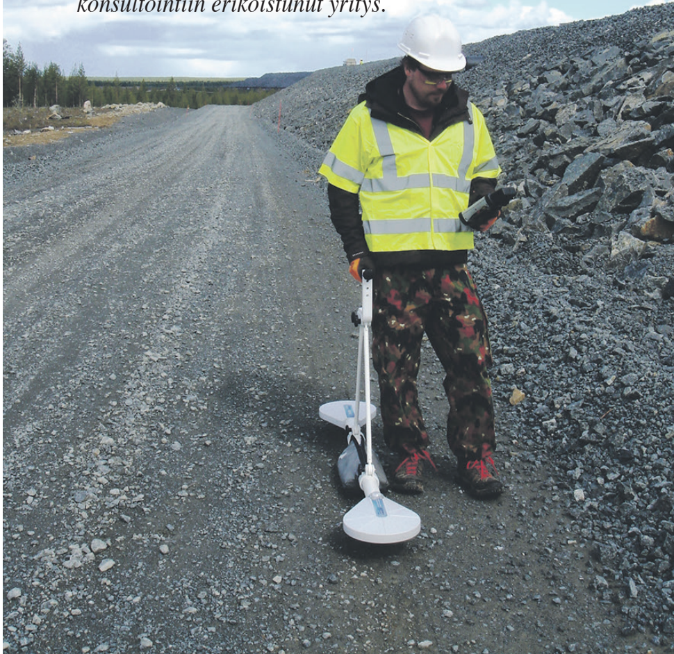
Patorakenteen monitorointia sen ulkoreunalta, mittaajana Geoston projektiasiantuntija Joonas Sorsa.
